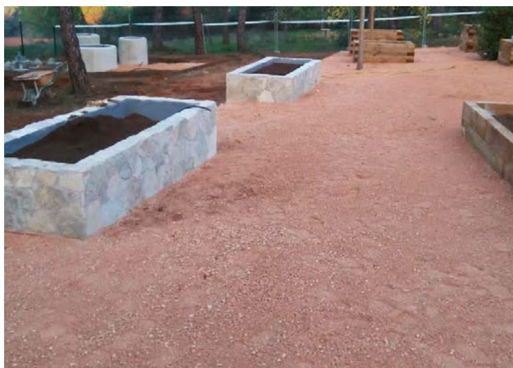
Εικόνα 28. Το DG πρέπει να συμπιεστεί αρκετά καλά αν θα χρησιμοποιείται από άτομα με αμαξίδιο. Φωτογραφία JTP
